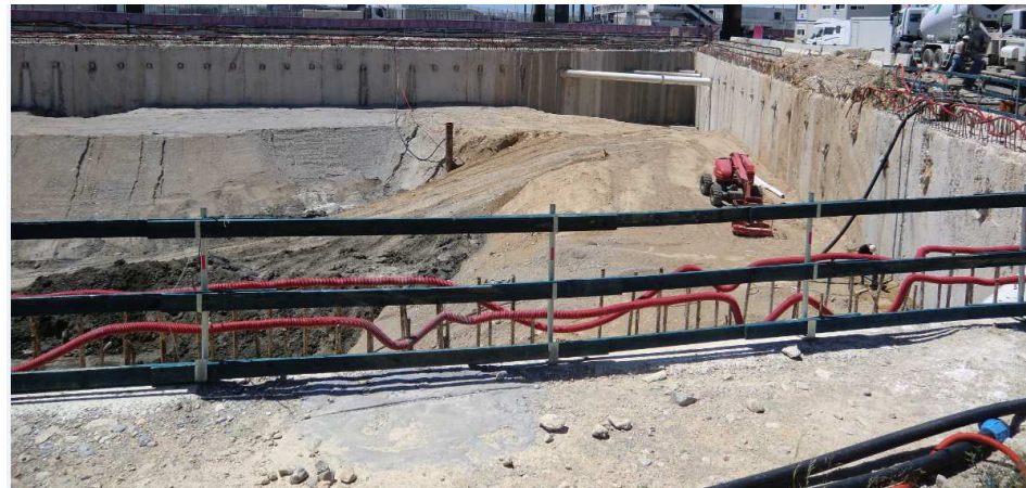
Etat de la fouille remblayée
