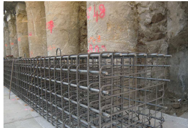
Ferrailage de la lierne du second niveau de butons
