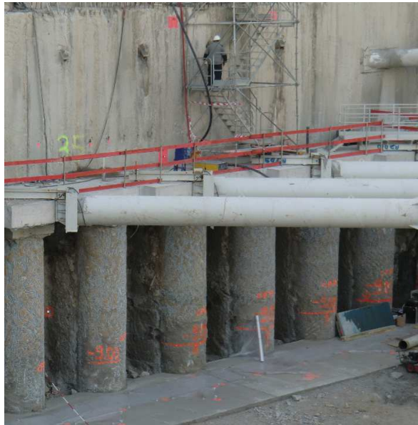
Premier lit de butons terminé et préparation de la lierne du second niveau de butons
