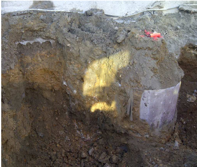
Le contrôle du « collage » colonne sol-ciment/pieu
