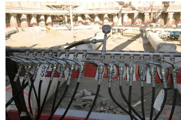
Le suivi et le contrôle de la pression des butons du second niveau
