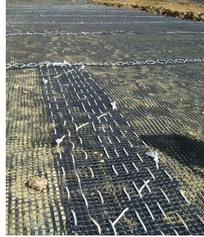
Face à un aléa géologique, et la reconnaissance de la présence de fissures ouvertes , une proposition de mesure compensatoire avec mise en place d'une géogrille de renforcement a été :
