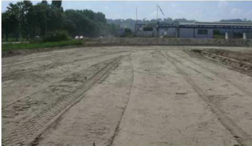
Préparation d'une arase terrassement propre, plane et peu agressive pour le géosynthétique de renforcement.
