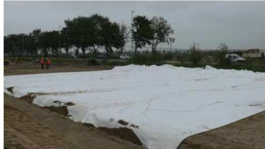
Mise en œuvre à plat et sans plis du géosynthétique de renforcement. Respect des 40 cm minimum de recouvrement latéral.
