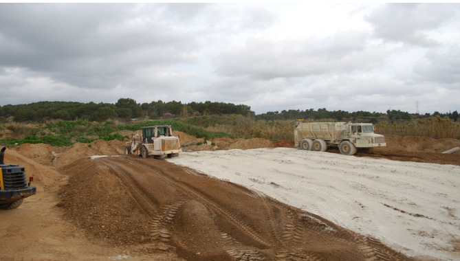
Stabilisation par ajout de chaux hydraulique
