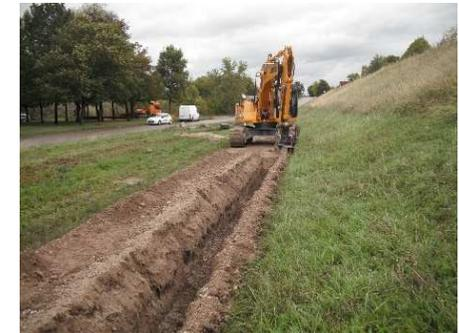
Installation de système de surveillance par fibre optique dans des ouvrages hydrauliques
