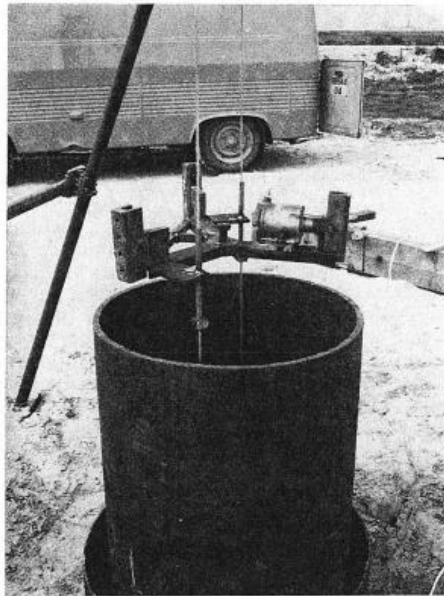
Fig. 10. — Descente du chapelet de bloqueurs à tripode dans le pieu tubulaire du Havre (août 1971).
