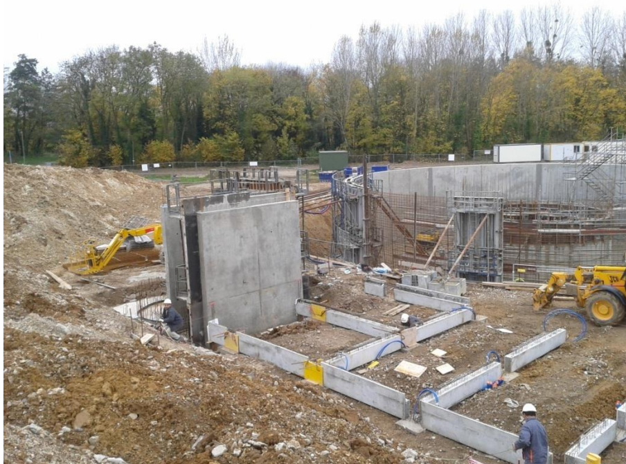
Figure 54 : tête de pieux (Géothermie-Professionnelle/Pinto)
