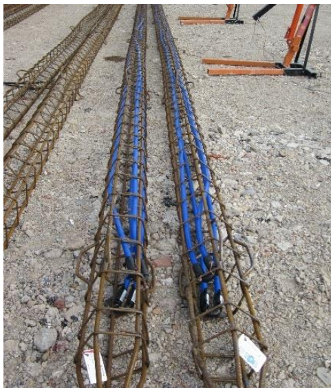
Figure 48 : Pieux énergétiques de petit diamètre (Géothermie-Professionnelle/Pinto)
