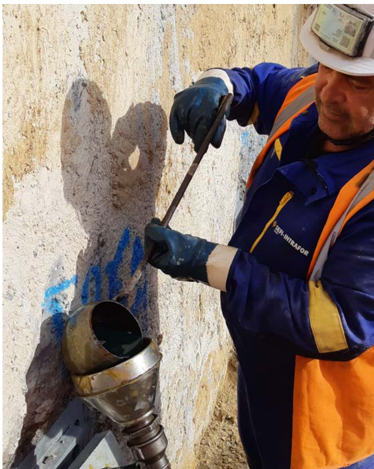
Photo 6.5 : remplissage du tube-trompette de produit anti-corrosion (cire)
