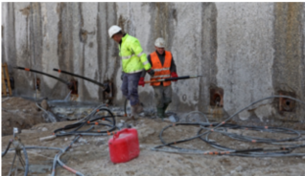
Photo 7.12 : mise en place de l'obturateur (© Spie Fondations)
