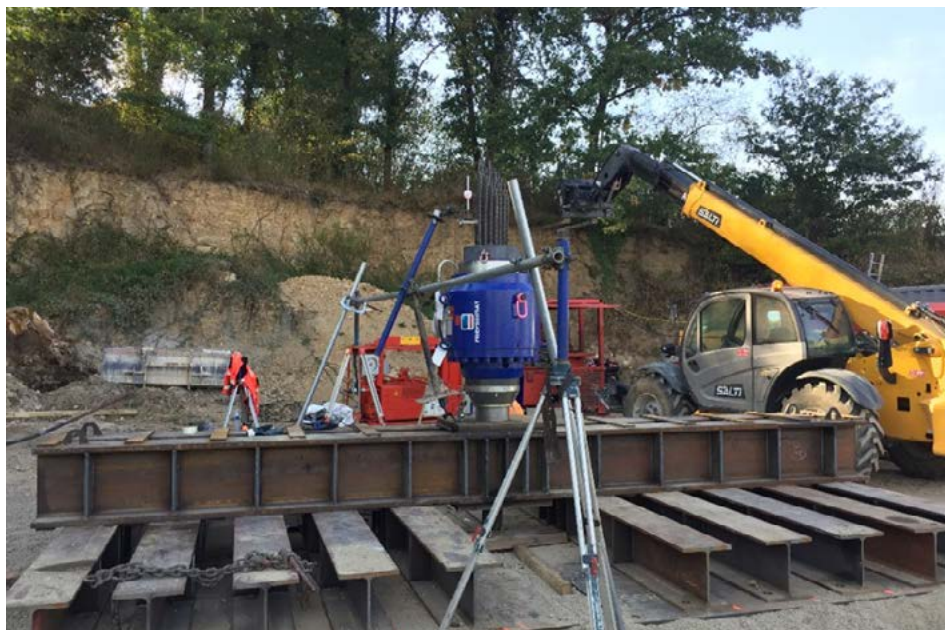
Photo I.1 : Structure d'appui d'essai de chargement (© Soletanche Bachy)
