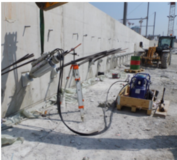
Photo 8.4 : essai de contrôle (© Soletanche Bachy)
