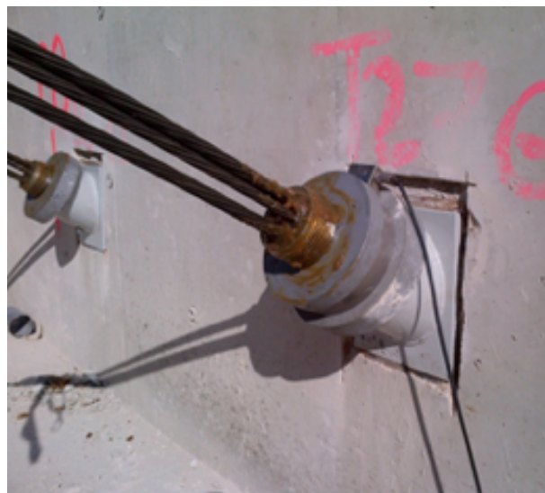
Photo 8.5 : tête de tirant instrumentée (© Freyssinet)
