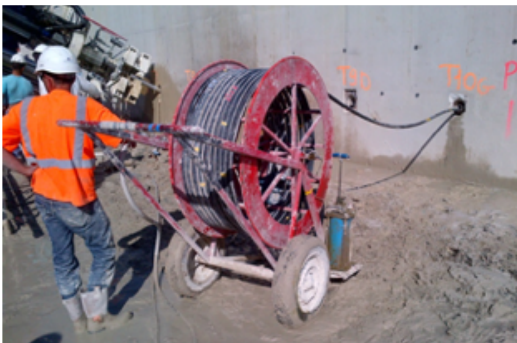
Photo 7.13 : injection de type IRS (©Freyssinet)
