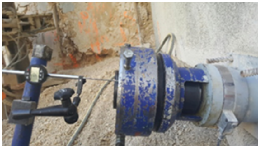
Photo 8.10 : pesage d'un tirant avec tête instrumentée (© Freyssinet)
