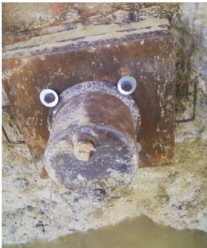
Photo 3.1 : exemple de capot de protection (© Sefi Intrafor)
