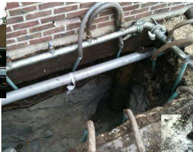
Découverte des pieux par fouille réalisée sous rabattement
