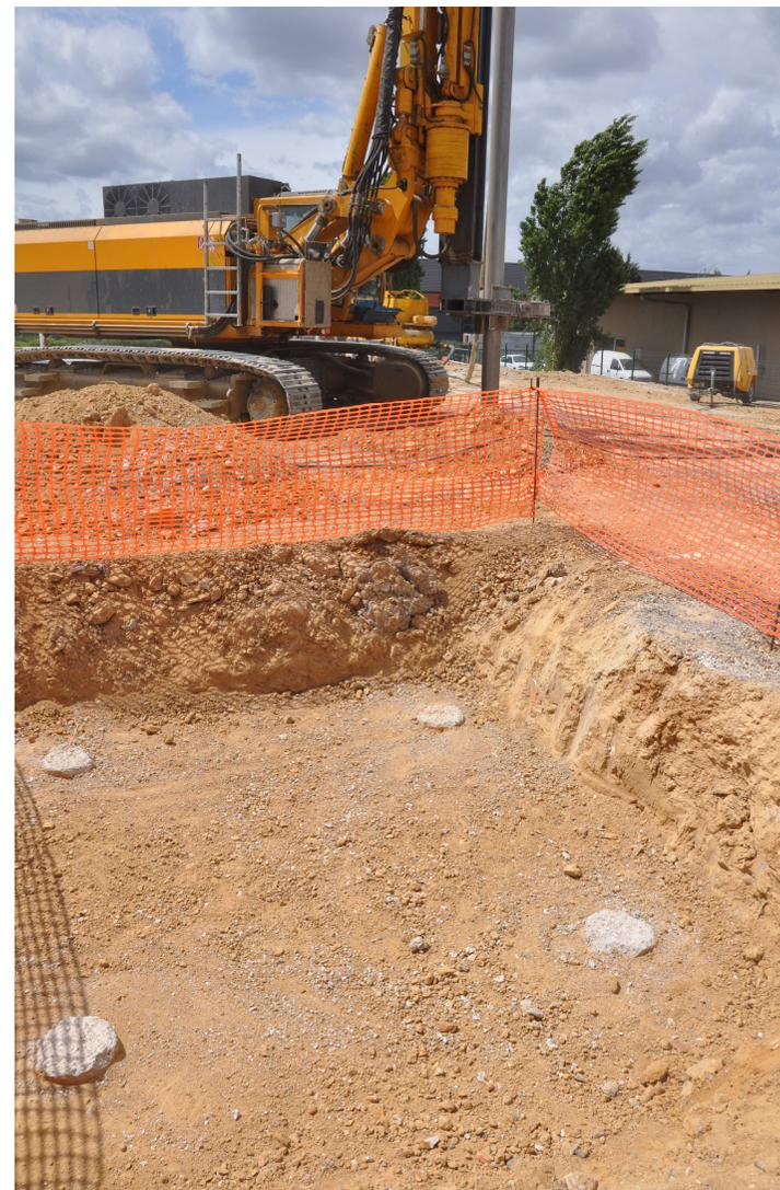
Dégarnissage des têtes d'IR avant recépage au marteau piqueur
