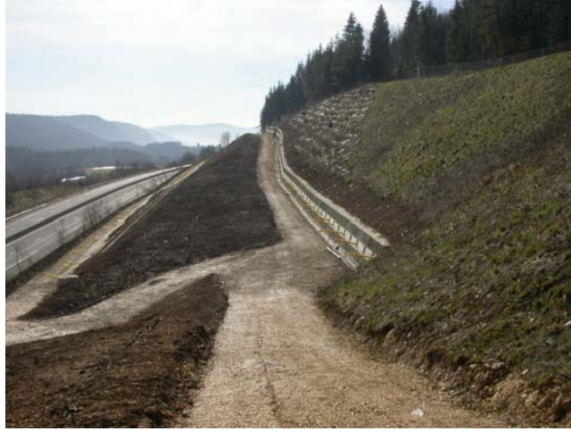
Vue générale des travaux
