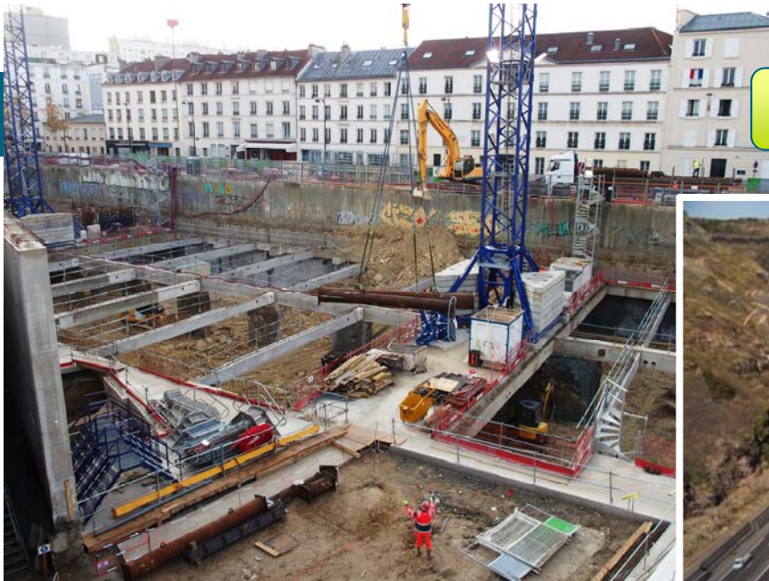
Les infrastructures du Grand Paris
