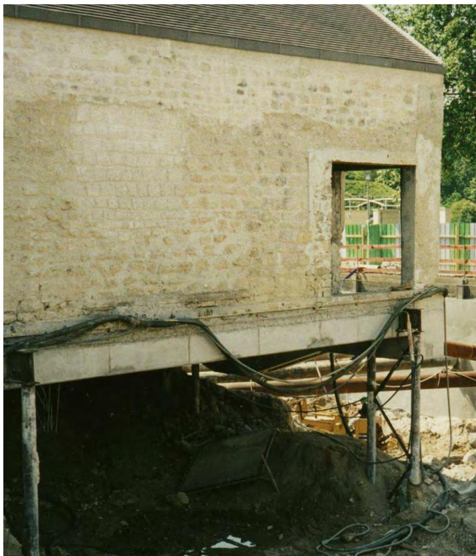
Poutre de reprise sous mur en maçonnerie.
