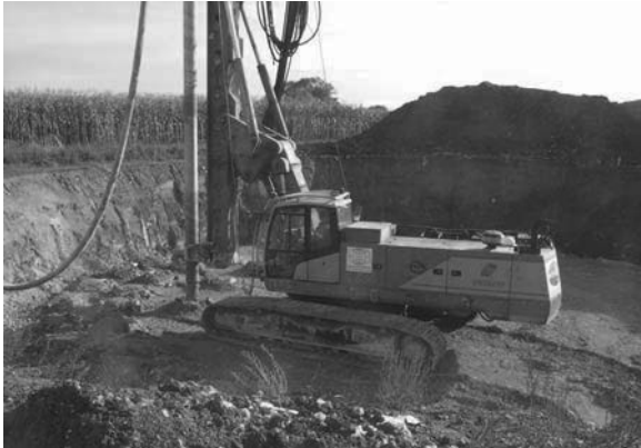
Figure 2. Forage et coulage des IR en fond de fouille.
