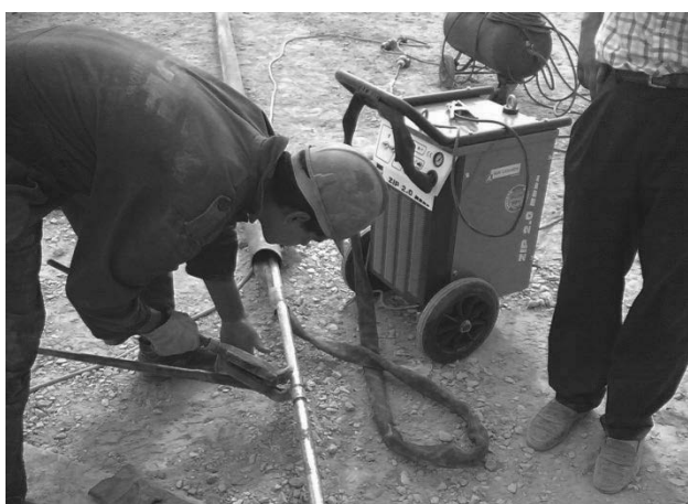
Figure 8. Procédé de perforation par oxycoupage au plasma
