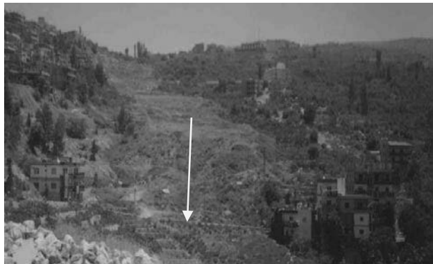
Figure 1. Vue globale du glissement dans le centre de la bourgade Essfiré. Le mouvement entre les maisons est indiqué par la flèche.
