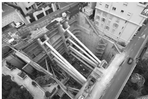
Figure 10. Vue du chantier – Phase réalisation du radier
