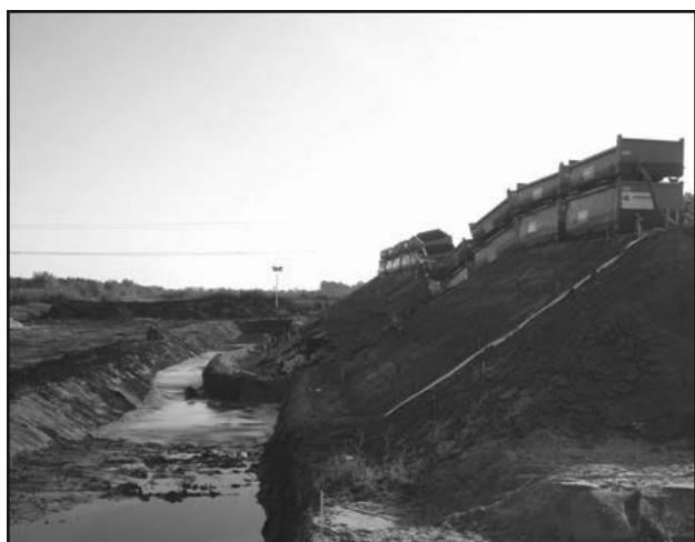
Figure 3 : Glissement de la digue (photo Koelewijn)
