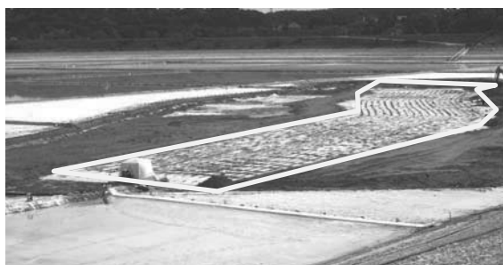
Figure 6. Vue depuis la crête de digue du bassin et de la zone instrumentée (en clair au centre).
