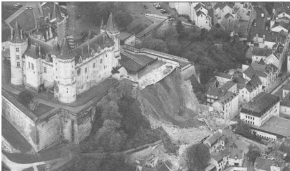
Figure 2 : Instabilité de versant due aux circulations d'eau
