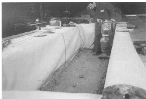
b) Compactage du matériau à la pilonneuse
